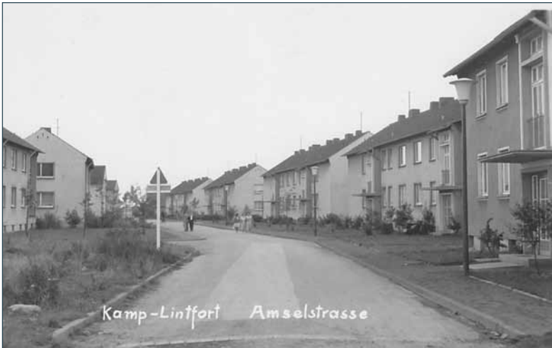
Abb. 66: Blick in die Amselstraße der „Bergmannssiedlung Niersenbruch“ um 1960; im Auftrag der Friedrich Heinrich AG errichtete Mietwohnblocks der Aachener Gemeinnützigen Wohnungs- und Siedlungsgesellschaft.
